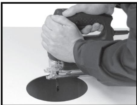
**Schritt 4.** Schneiden Sie ein Abzugsloch in das Gehäuse der Maschine.
